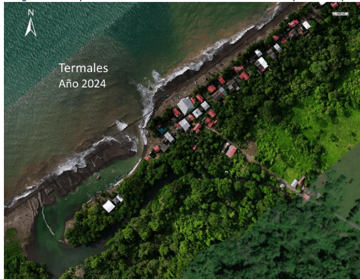
Área afectada por la erosión y recuperada con intervenciones antrópicas -Corregimiento de Termales
